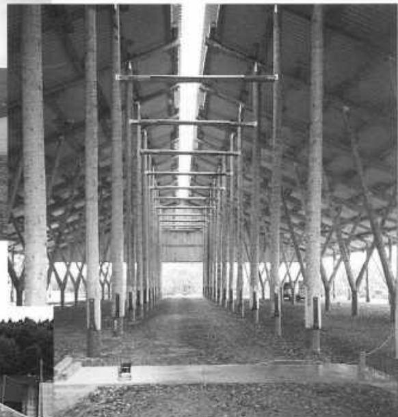
Foto oben: der offen First dient der guten Entlüftung des Stalles
