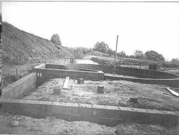
Fundamente: im Hintergrund ist das Fundament des Karussells zu erkennen.
