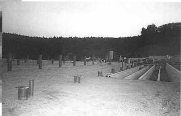
Die Punktfundamente für die Rundholzbinder
