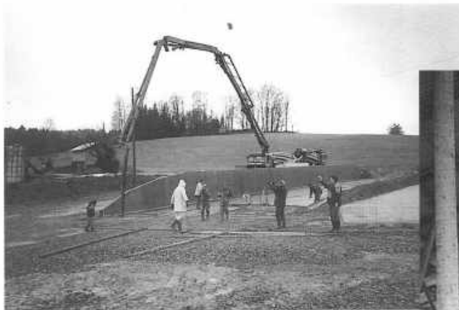
Silobau: 2 Stück, je 50 m lang, 10 m breit, je 1000 m 3
