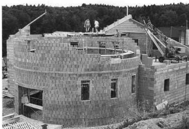
Silobau: 2 Stück, je 50 m lang, 10 m breit, je 1000 m 3
