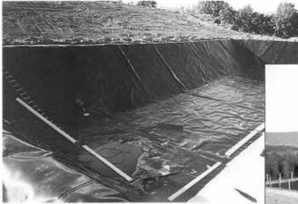
Die Folienbahnen im Gülleteich wurden verschweißt und die Schweißnähte auf Dichtheit geprüft.
